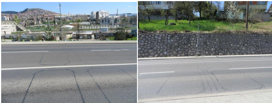
Slika 2. Automatski brojač saobraćaja sa induktivnom petljom
