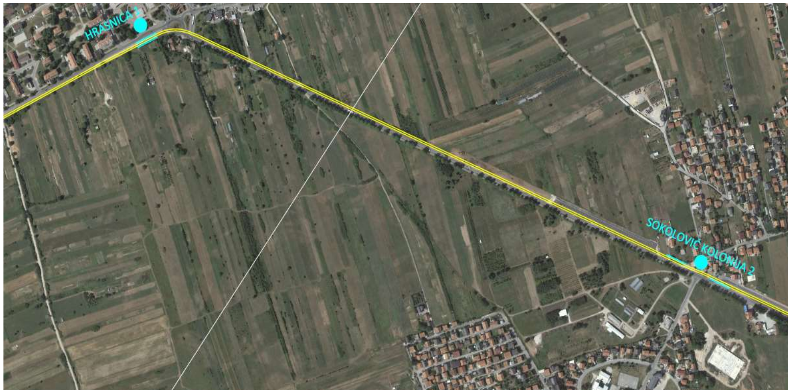
Slika 5 Treća dionica tramvajске pruge od Sokolović kolonije 2 do Hrasnice 1
